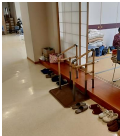
複数回転倒があった場所への 置き型手すりの設置
